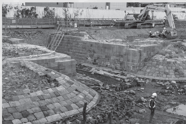
写真4 第七橋梁橋台部
